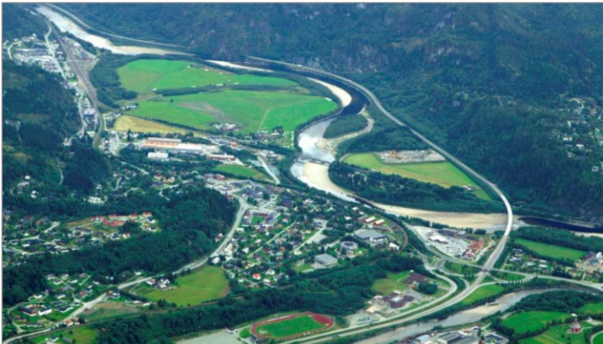
Figur 5-1: Oversiktsbilde fra Støren sentrum med Prestteigenkrysset nede til høyre. Eksisterende E6 nordover dalen øst for Gaula.
