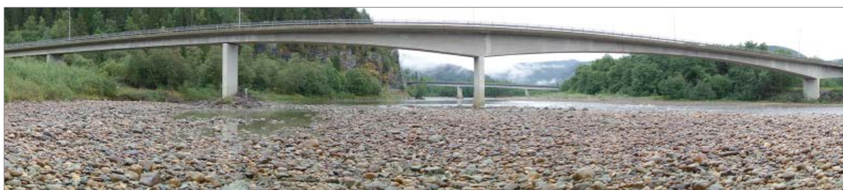
Figur 7-18: Eksisterende bru over Gaula. I bakgrunnen sees fv. 632 Folstad bru. Kilde: Norconsult.
